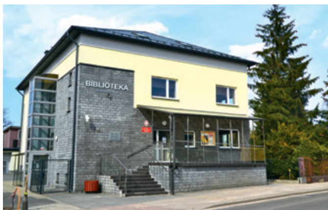
Budynek Gminnej Biblioteki Publicznej w Mrozach
