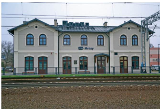
Widok po remoncie od strony torów
