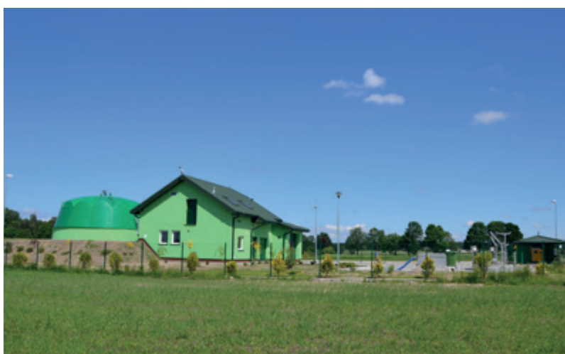
Oczyszczalnia ścieków w Jeruzalu
